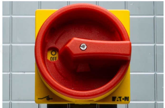
Bild 9: ... Hauptschalters an der Schaltschranktür
